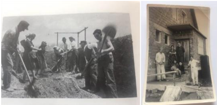
Abbildung 2 Ausheben der Baugrube / Studentische Helfer mit Bauherrschaft
