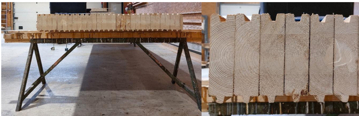
a) Querschnitt des Bauteils auf einem Stahlbock
