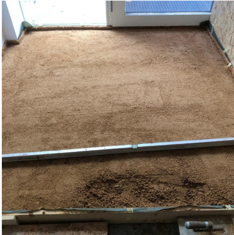
Abbildung 29: BioScreed Großmuster für Versuche
