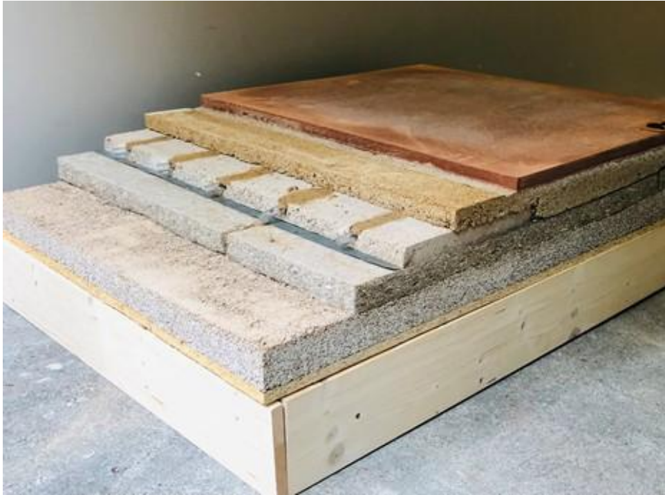
Abbildung 31 Transportables Modell eines beispielhaften Fußbodenaufbaus in der Größe eine Europalette.
