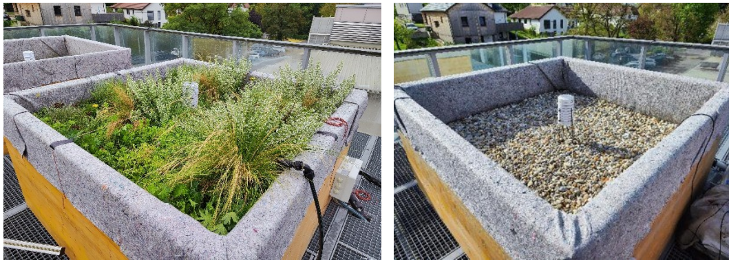
Abbildung 10: Dachtteststände: reduziert-intensive Begrünung 4 Monate nach Anlage (links) und Referenz-Kiesdach (rechts). Fotos: M.Majcen
