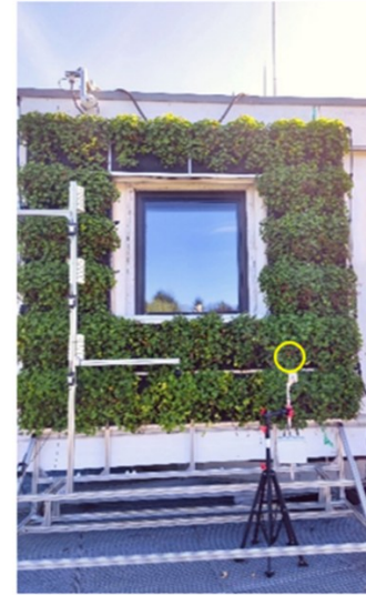
LV (Living Wall), Bild vom 4.8.2025
