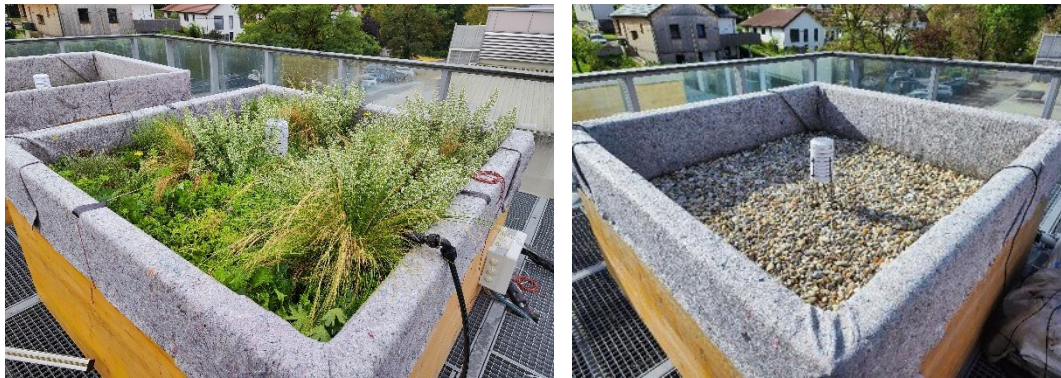
Abbildung 10: Dachteststände: reduziert-intensive Begrünung 4 Monate nach Anlage (links) und Referenz-Kiesdach (rechts). Fotos: M.Majcen
