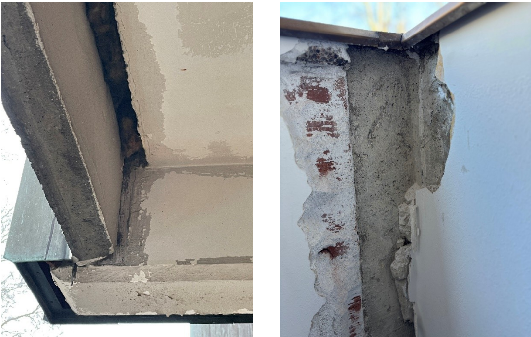
Abbildung 18: Brüstungsecke Loggia, RfM Architektur
