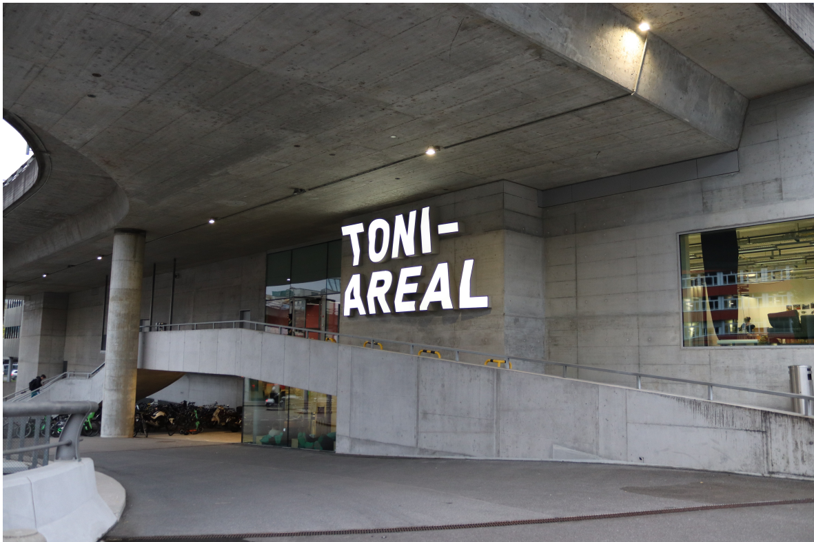
Abbildung 2: Foto des Toni-Areals in Zürich, TU Wien
