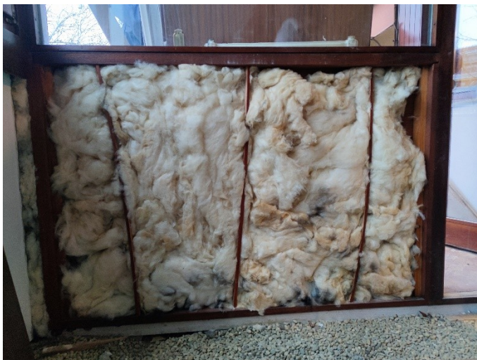
Abbildung 14: Holzwand zur Loggia, RfM Architektur
