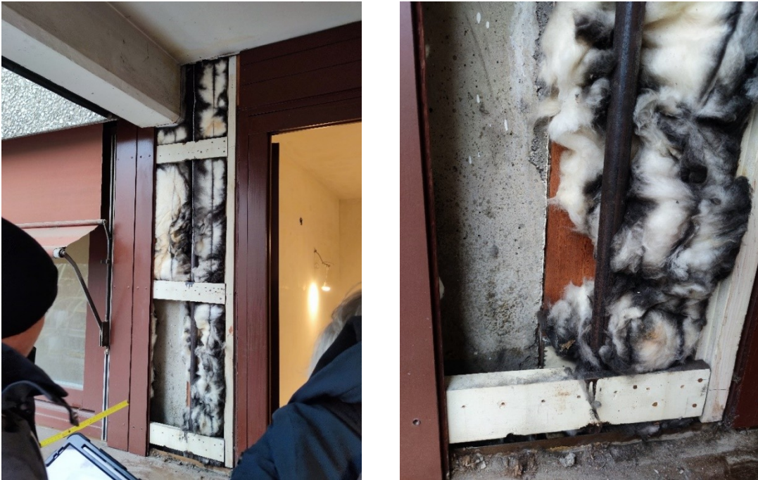
Abbildung 11: Anschluss Brüstung zur Innenwand, RfM Architektur
