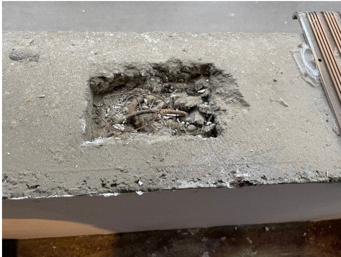
Abbildung 13: Brüstung Loggia, RfM Architektur
