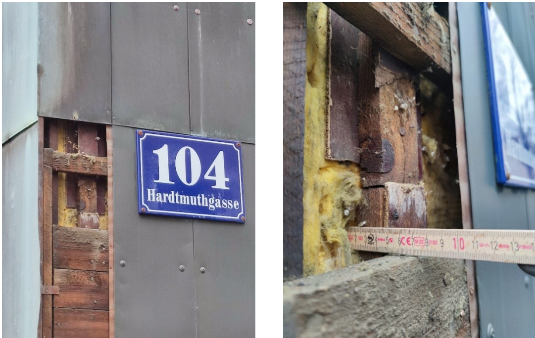
Abbildung 10: Fassadenaufbau, RfM Architektur
