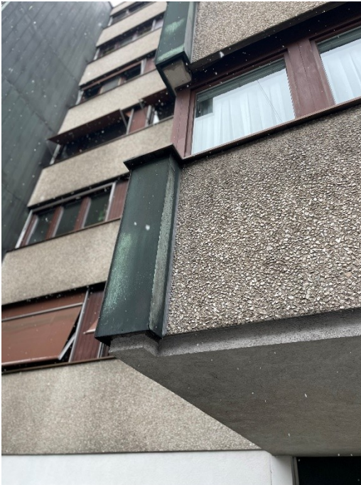
Abbildung 16: Eckverbindung Außenwand Wohnzimmer, RfM Architektur
