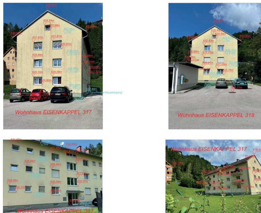
VERMESSUNG - Außenanlagen, Baukörperhöhen, Geschossdecken und Fenster
