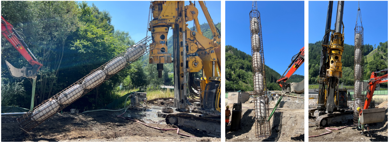
Abbildung 18: Einbringen des Bewehrungskorbes in das Bohrloch zur anschließenden Betonage ©Philip Wehbe, ITE TU Graz
