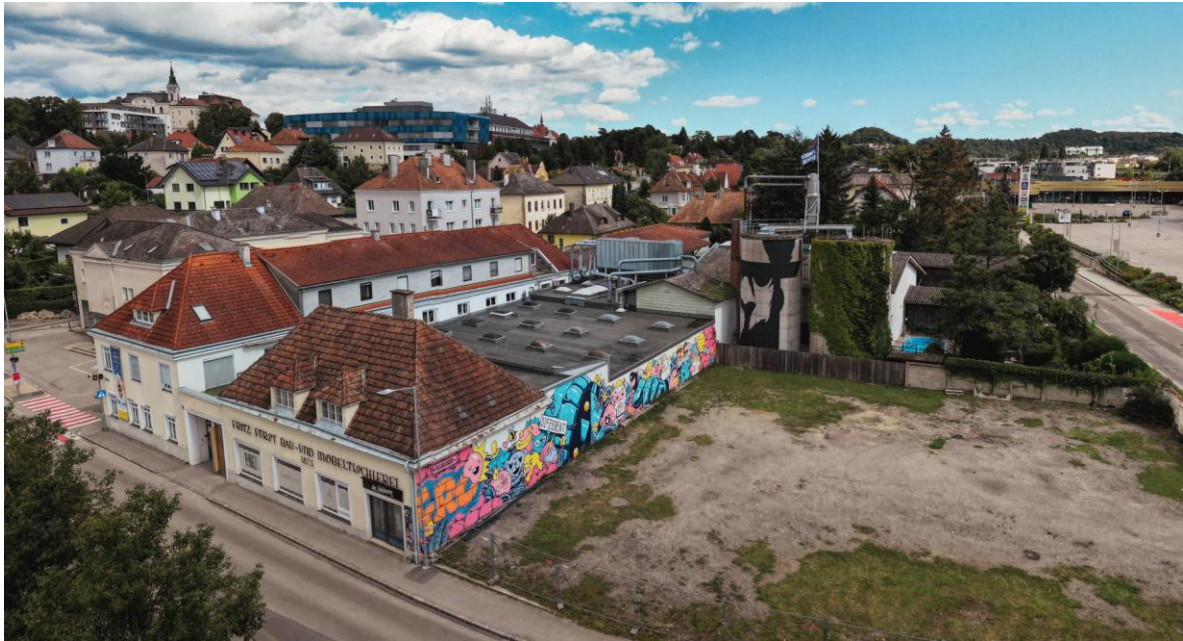
Abbildung 4: Einer der beiden Silos sowie die südliche Begrenzungswand der „Tischlerei Melk“ wurden im Jahr 2024 künstlerisch gestaltet (Quelle: Fürst Holding GmbH)
