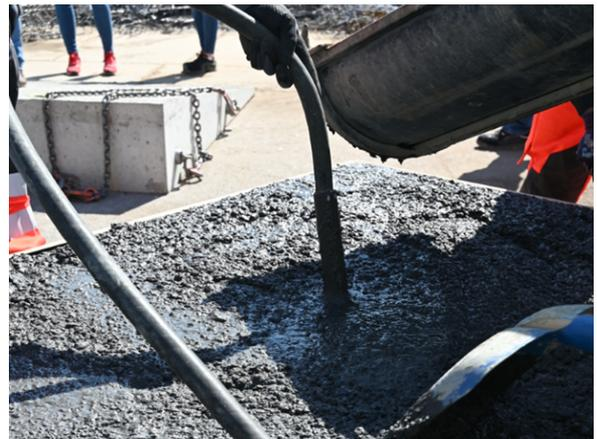
Abb. 16: Schritt 2 = Verdichten des RCC2+-Betrns mittels Rüttler
