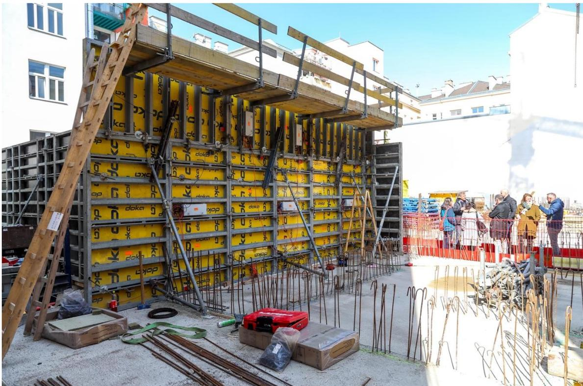
Abb. 45: Baustellenfoto Projekt SOLEY, Strabag SRE; Einsatz heizbare Schalung und CO<sub>2</sub>-reduzierter Beton (Fotocredits: Christian Fürthner)
