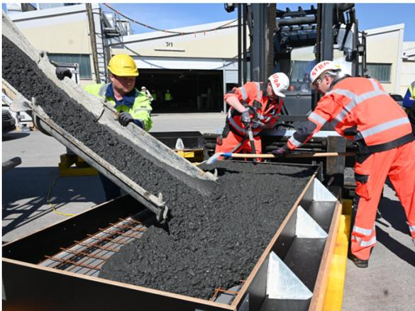
Abb. 15: Schritt 1 = Einfüllen des RCC2+-Betrns in Deckenschalung
