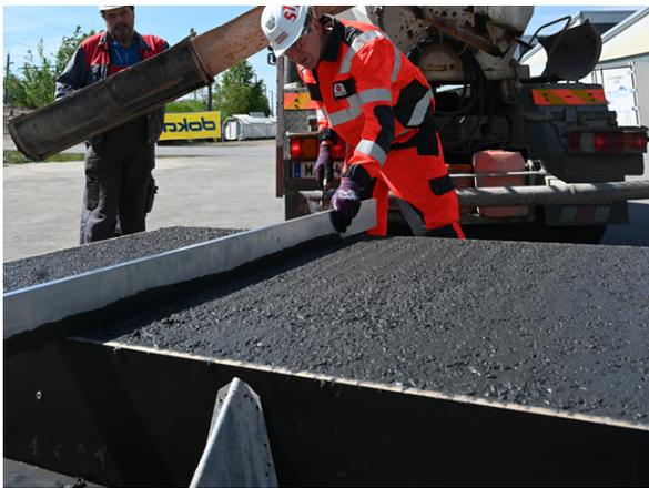
Abb. 17: Schritt 3 = Abziehen der Decke RCC2+
