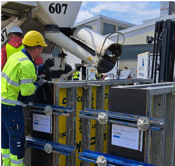
Abb. 21: Einfüllen Beton in Wandschalung
