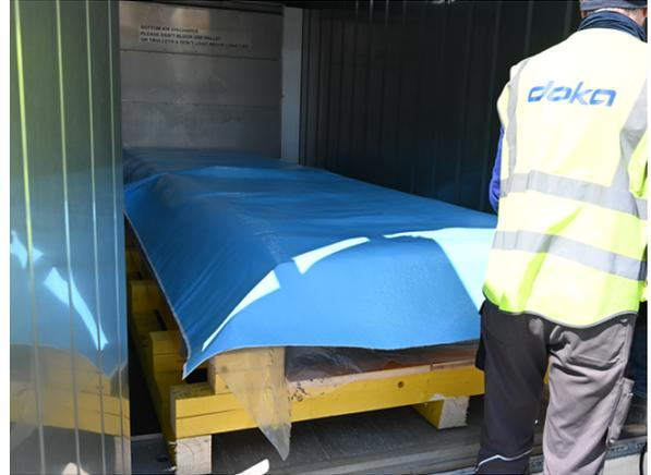
Abb. 20: Schritt 6 = Auflegen Winterschutzmatte
