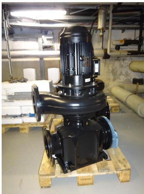
Abbildung 17: Hocheffiziente Filterpumpen vor der Montage.
