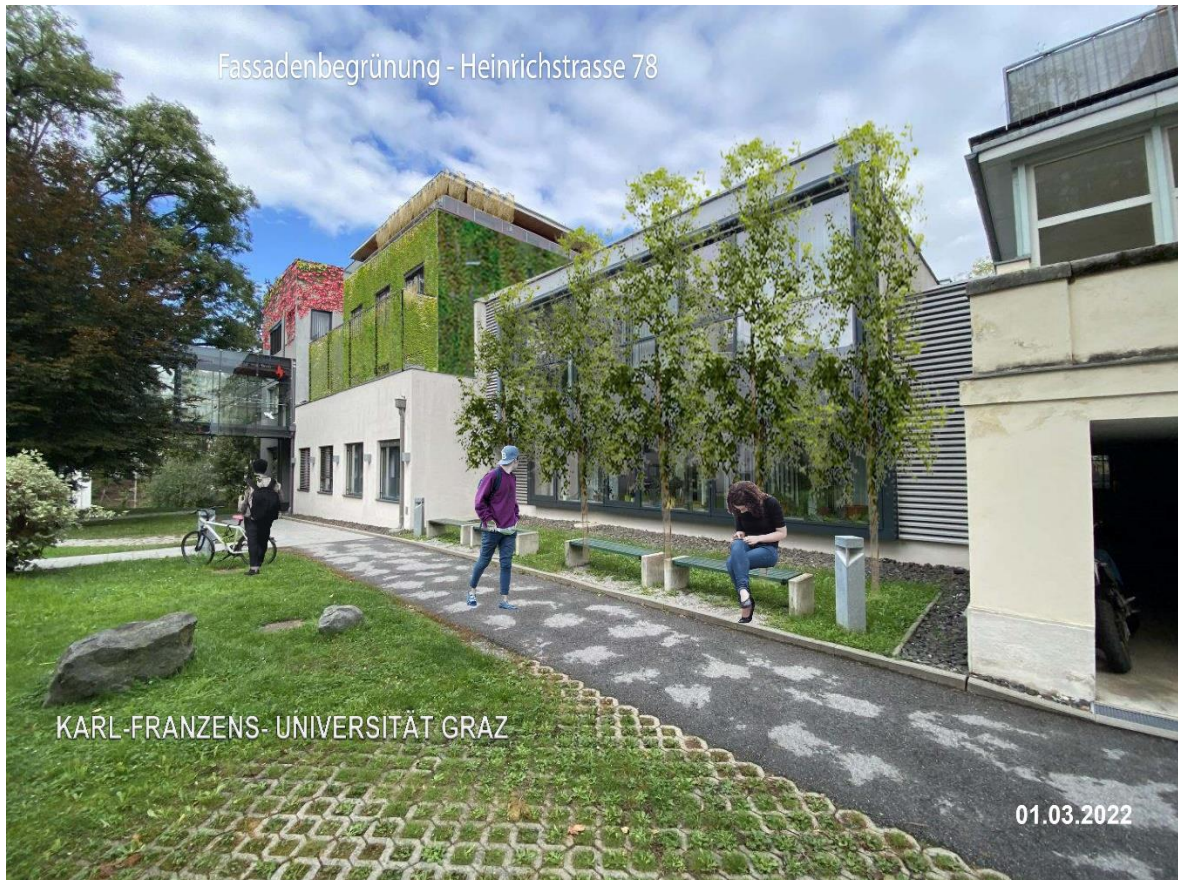
Abbildung: Fassadenbegrünung – Heinrichstraße 78
